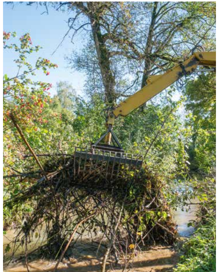
Der Mistgreifer entfernt den Biberdamm.
