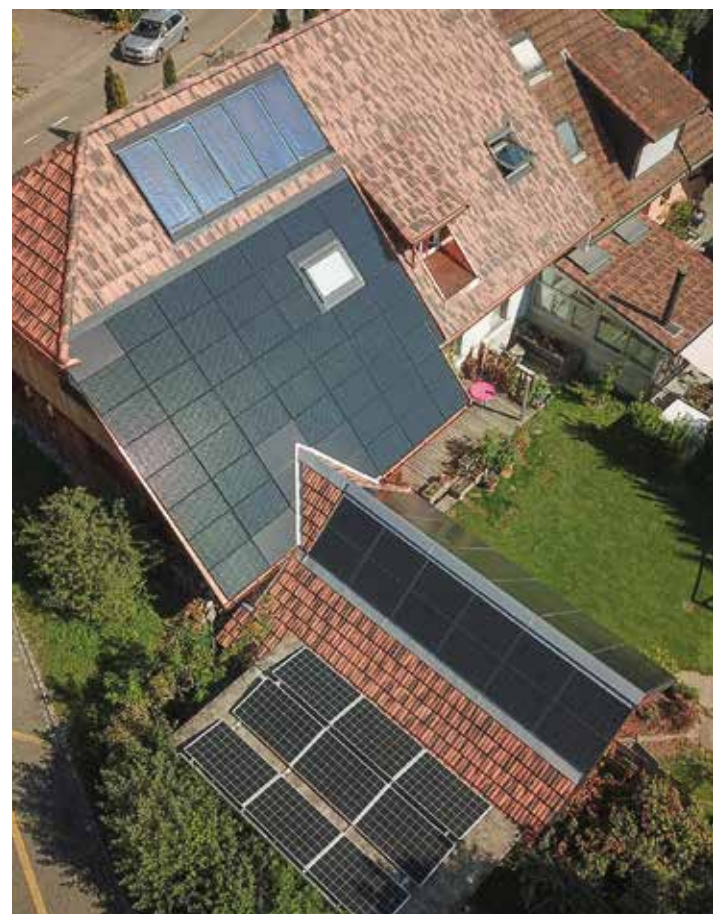
Das Beispiel in Reinach AG zeigt: Alte Häuser können problemlos in Netto-Plusenergiehäuser umgebaut werden.
